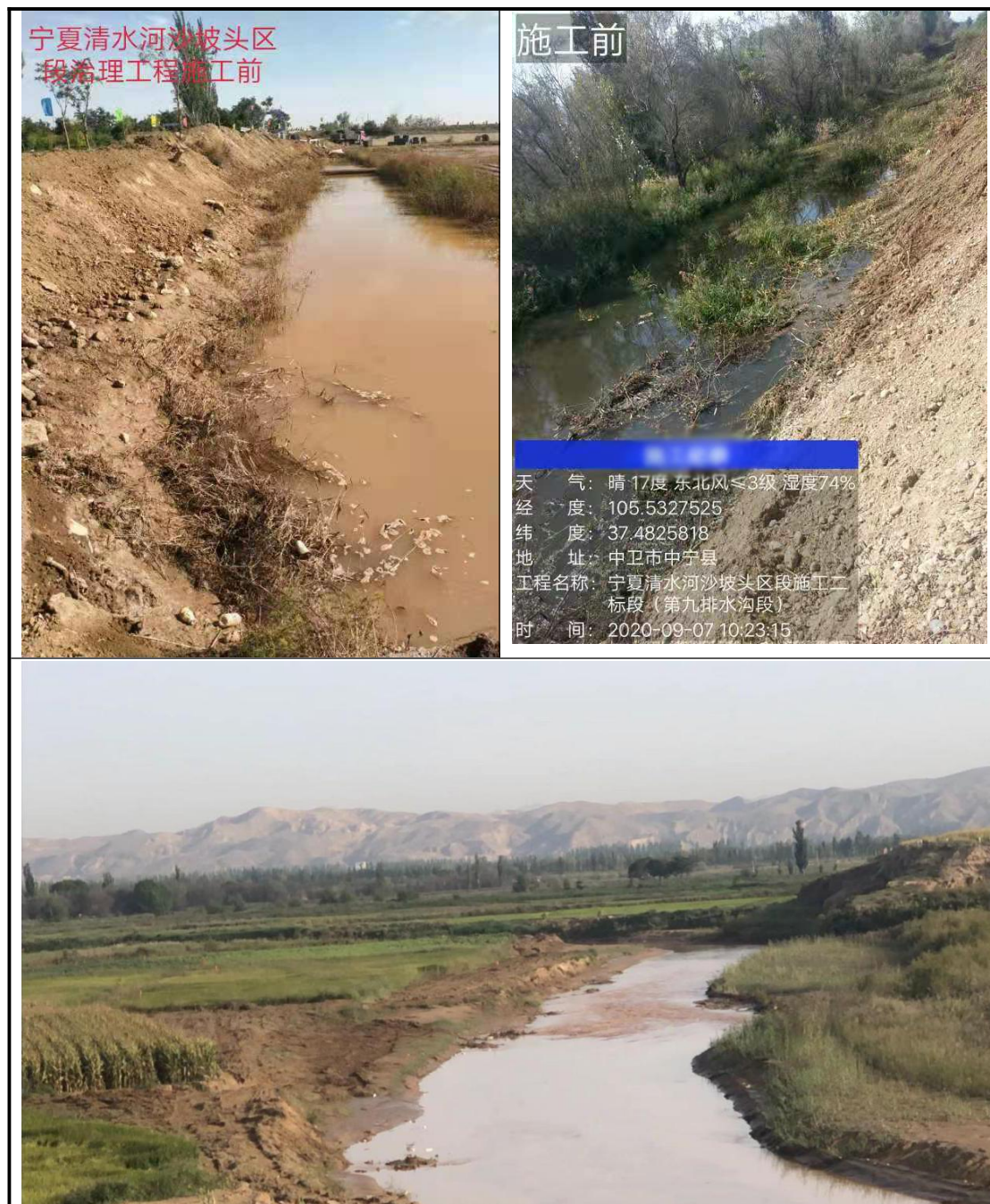
图9.本项目现场照片
