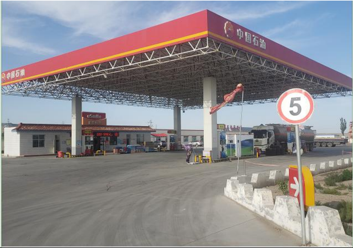
项目现场图片
