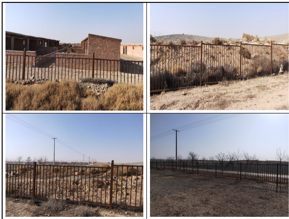
图 2.1-2 现有工程现场照片图
