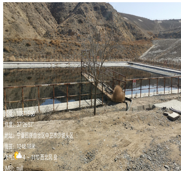
填埋场调节池现状
